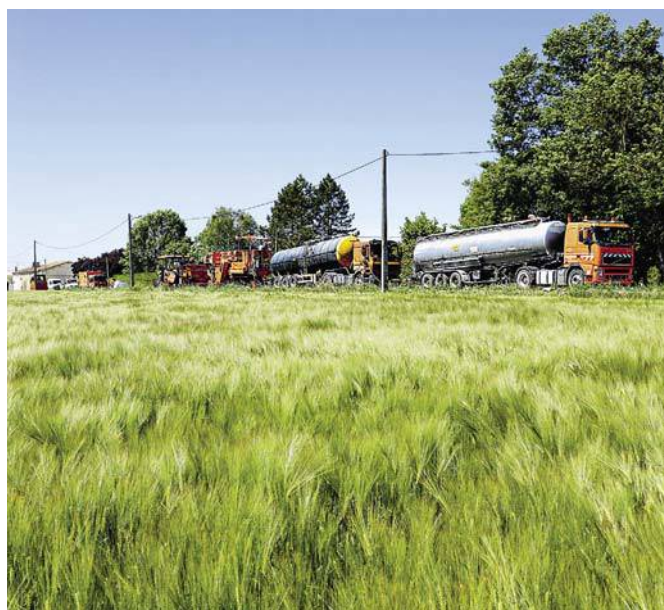
Recyclage de chaussées in situ : procédé Novacol sur une route départementale de Charente-Maritime, en France.
