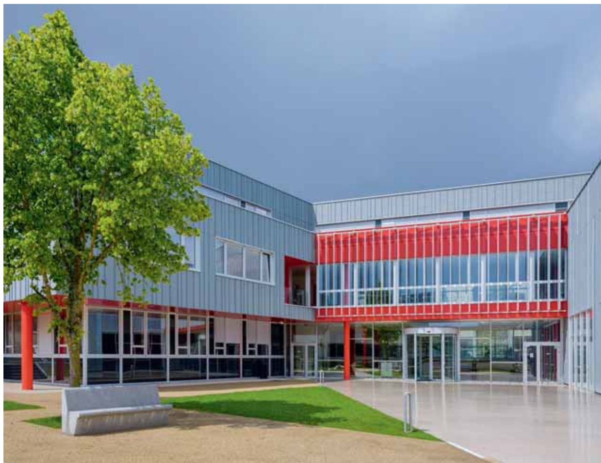
Situé à Magny-les-Hameaux, en région parisienne, sur le site du Campus Scientifique et Technique de Colas, «Echangeur Magny» accueille les collaborateurs des sièges de Colas Ile-de-France Normandie et d'Aximum depuis début 2015.
