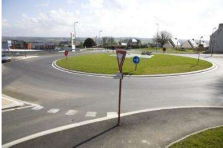
Roundabout in Côtés d'Armor, France
